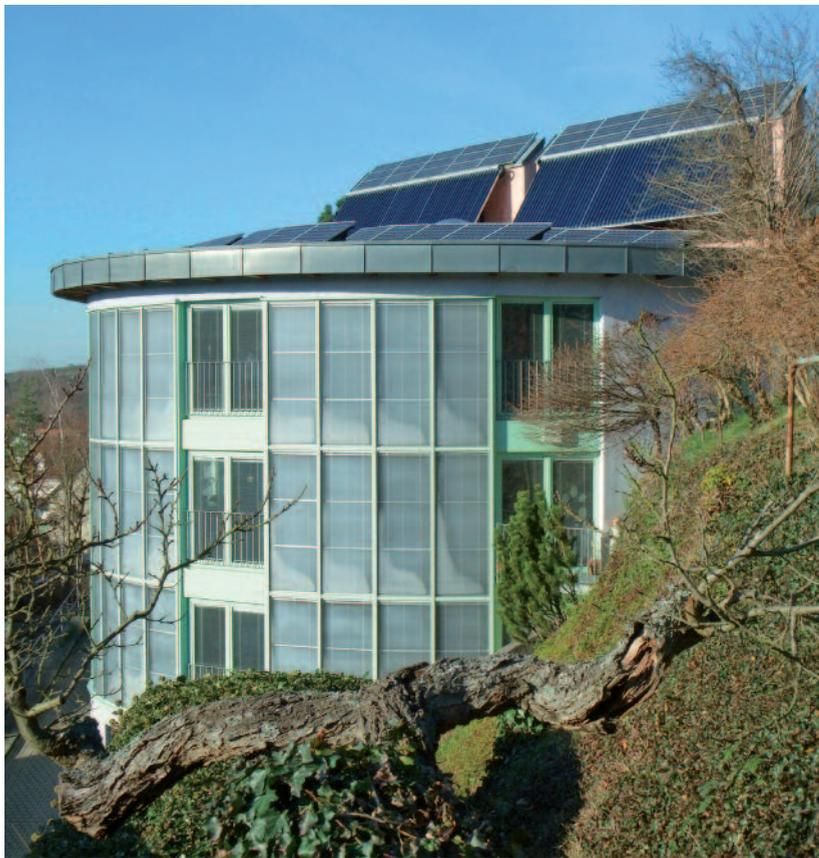
◀ Bild 8 • Solarhaus Abrecht mit 356 m<sup>2</sup> Nutzfläche, 24 m<sup>2</sup> CPC-VRK mit 840-l-Kombispeicher erzielen trotz 772 Stunden in Stagnation 5500 kWh/Jahr bzw. 55 % solaren Deckungsbeitrag.
