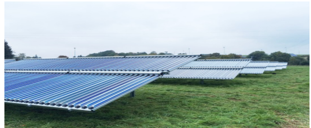
Abb. 15: Verschattungsarme Ständerung von CPC-VRK
