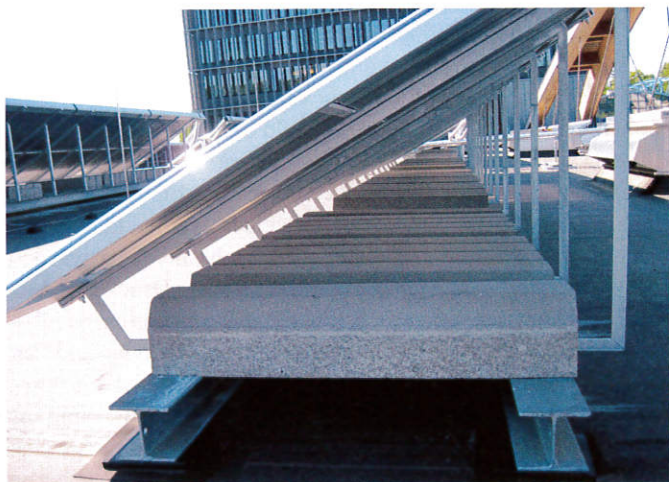
◀ Abbildung 5: Ballastierung
