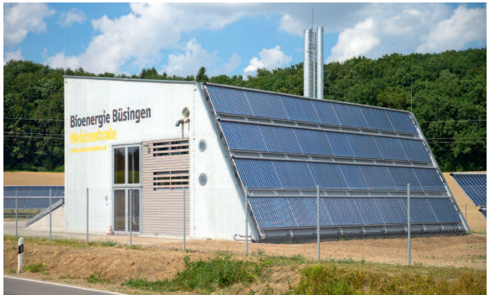
Bild 8 • Zentrale Einspeisung von ca. 550MWh/a bei 80-95 °C in ein Nahwärmenetz in Büsingen (Deutschland/Schweiz) mit 1090 m 2 Plasma-CPC-VRK seit 2013
