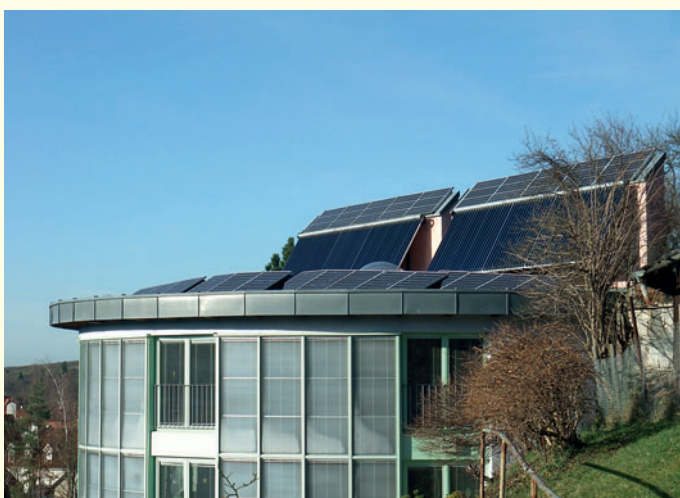
Abb. 2 · Zwei XL-Solarhäuser in Passivbauweise mit ca. 30 bzw. 80 Litern Kombispeicherkapazität pro Quadratmeter Kollektorfläche und mehr als 50 Prozent solarer Deckung für Warmwasser und Heizung.
